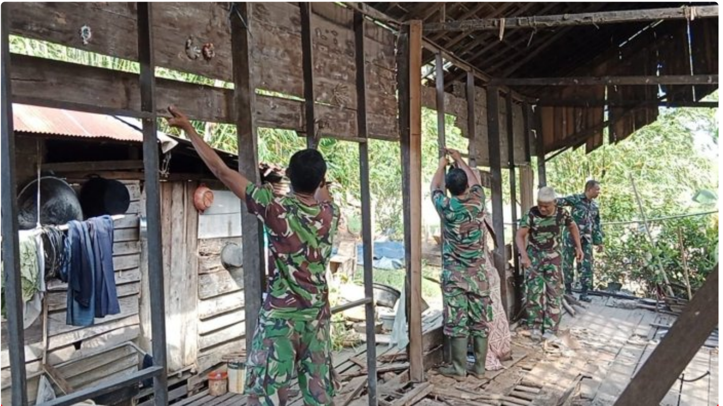
Hari ke Dua Bantuan Rehab RTLH Kodim 1006/Bjr, Bangun Tiang dan Rangka Rumah
