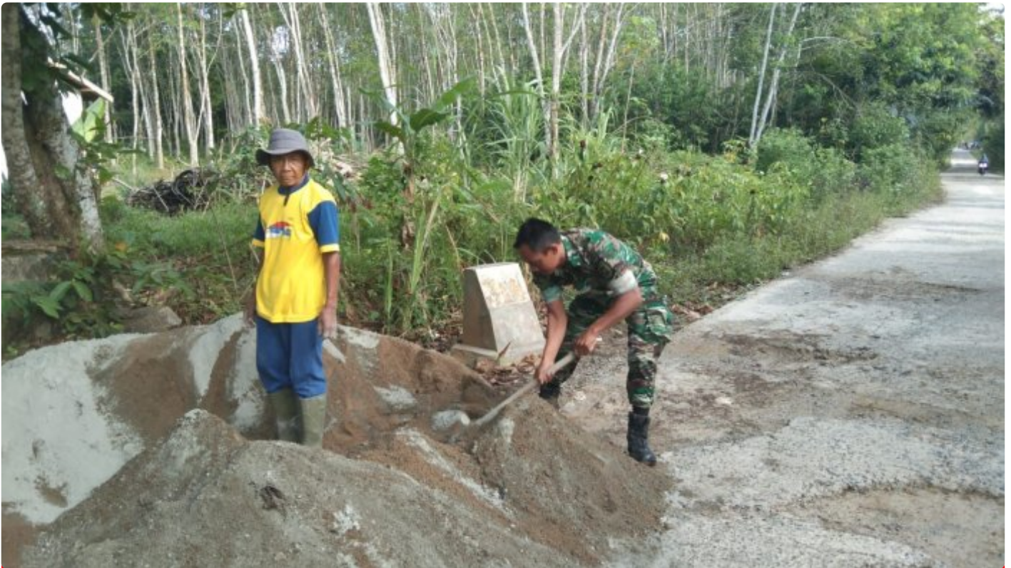
Babinsa Bantu Gotong Royong Pengecoran Jalan
